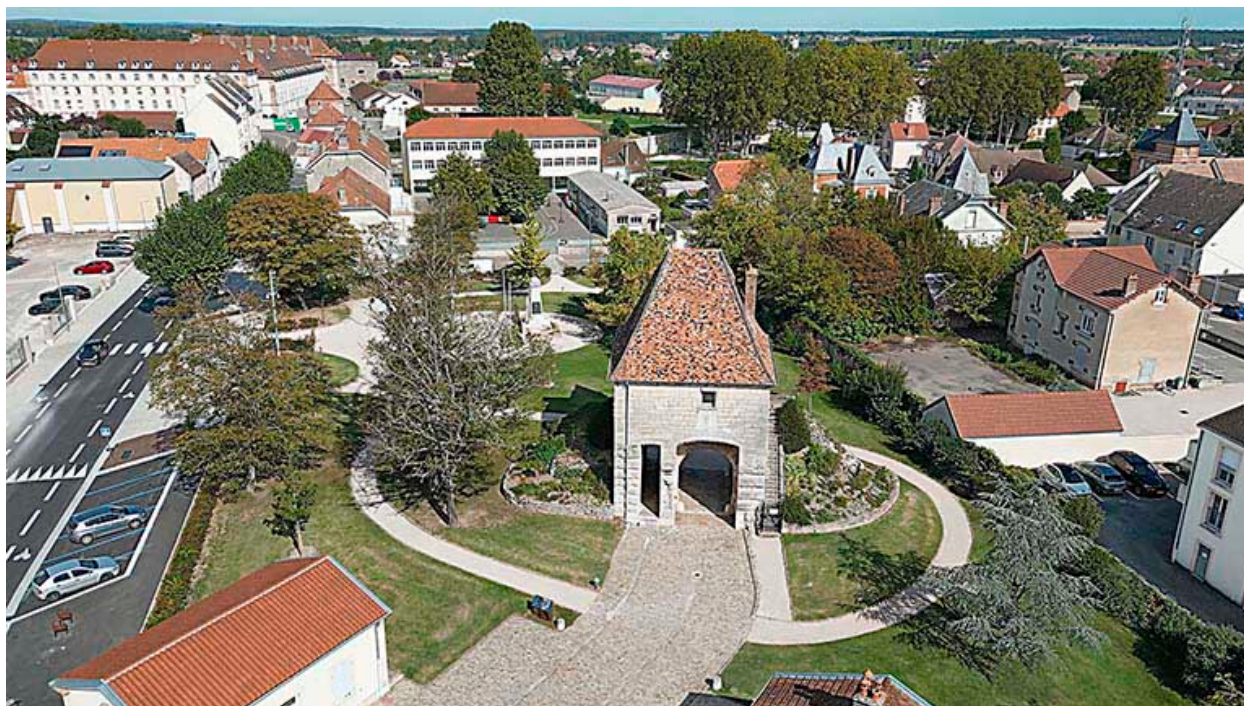
Vue aérienne de la porte.
