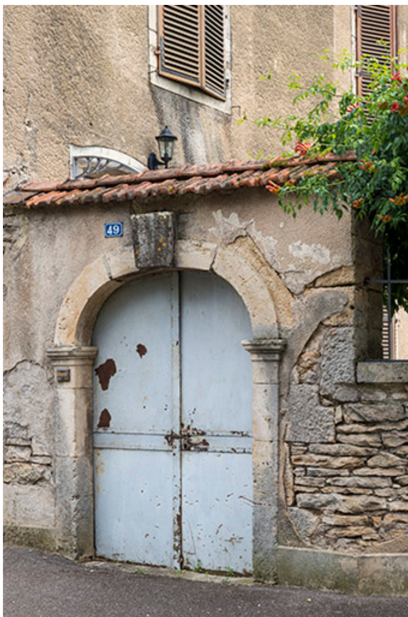
Détail du portail d'entrée.
