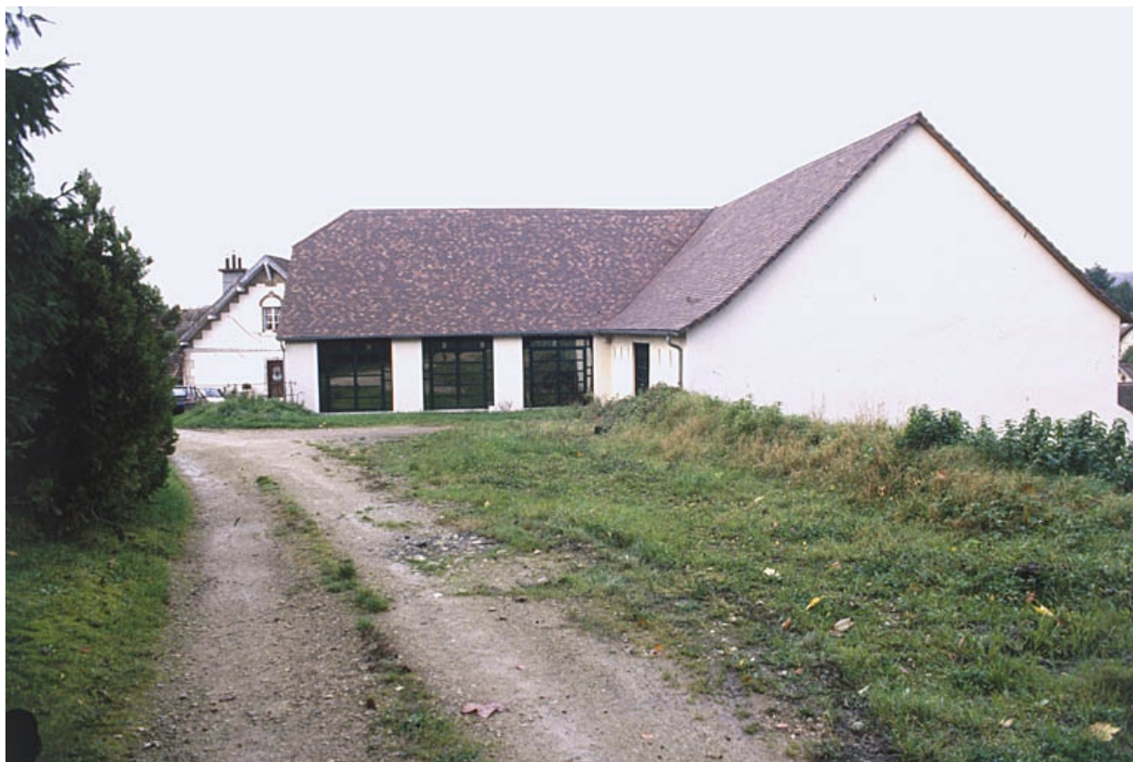
Ancienne halle à charbon depuis l'est.
