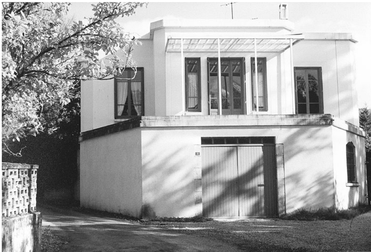
Façade antérieure avant restauration, novembre 1990.
