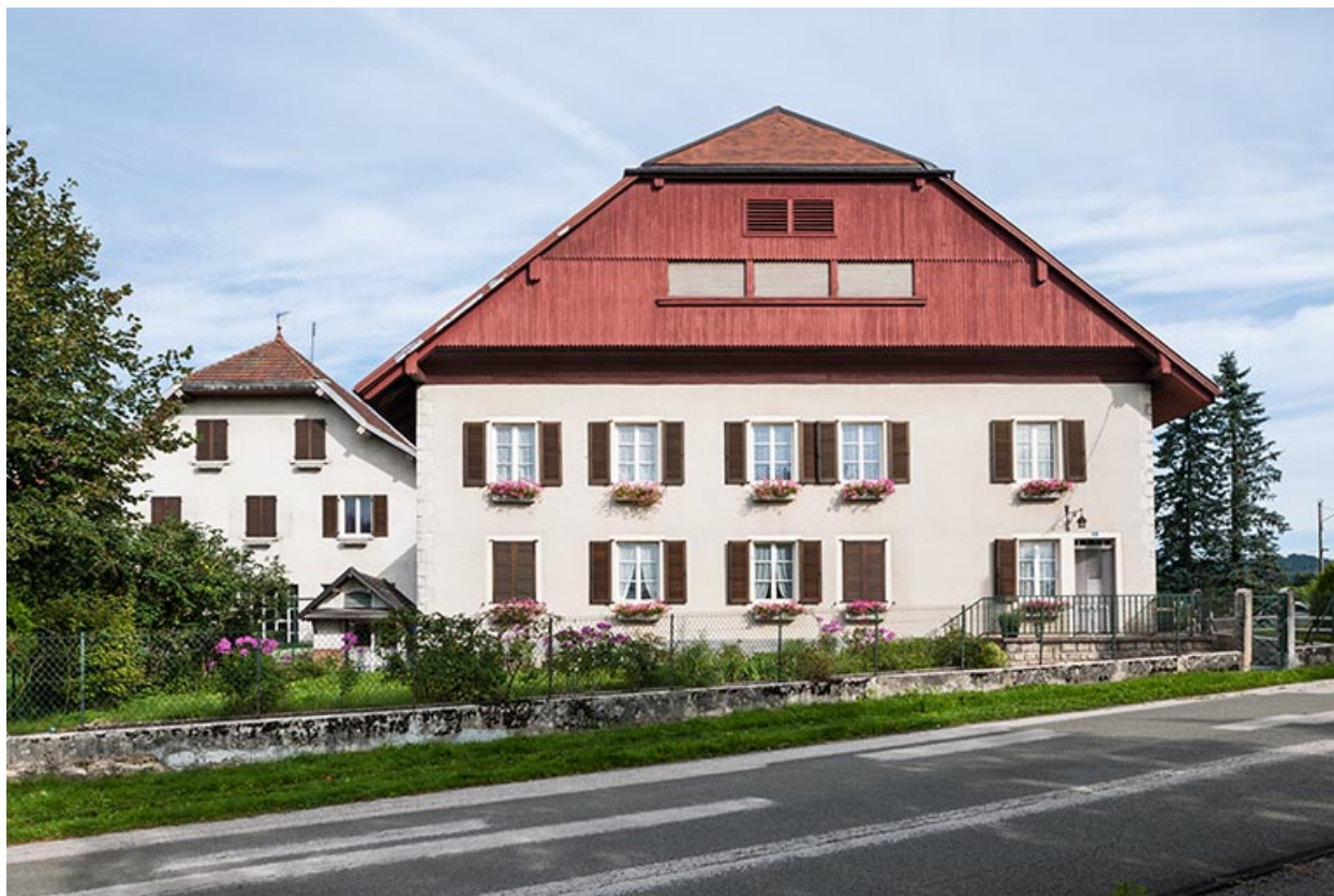
Façade sud de bâtiment (côté logement).
