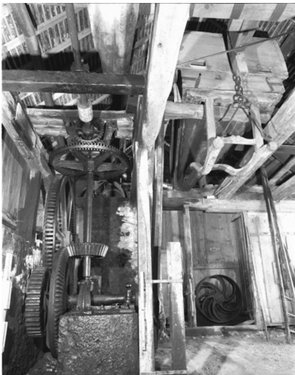
Vue d'un soufflet et du mécanisme.
