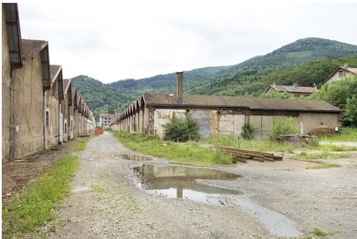
Ateliers de fabrication depuis le sud-ouest.
