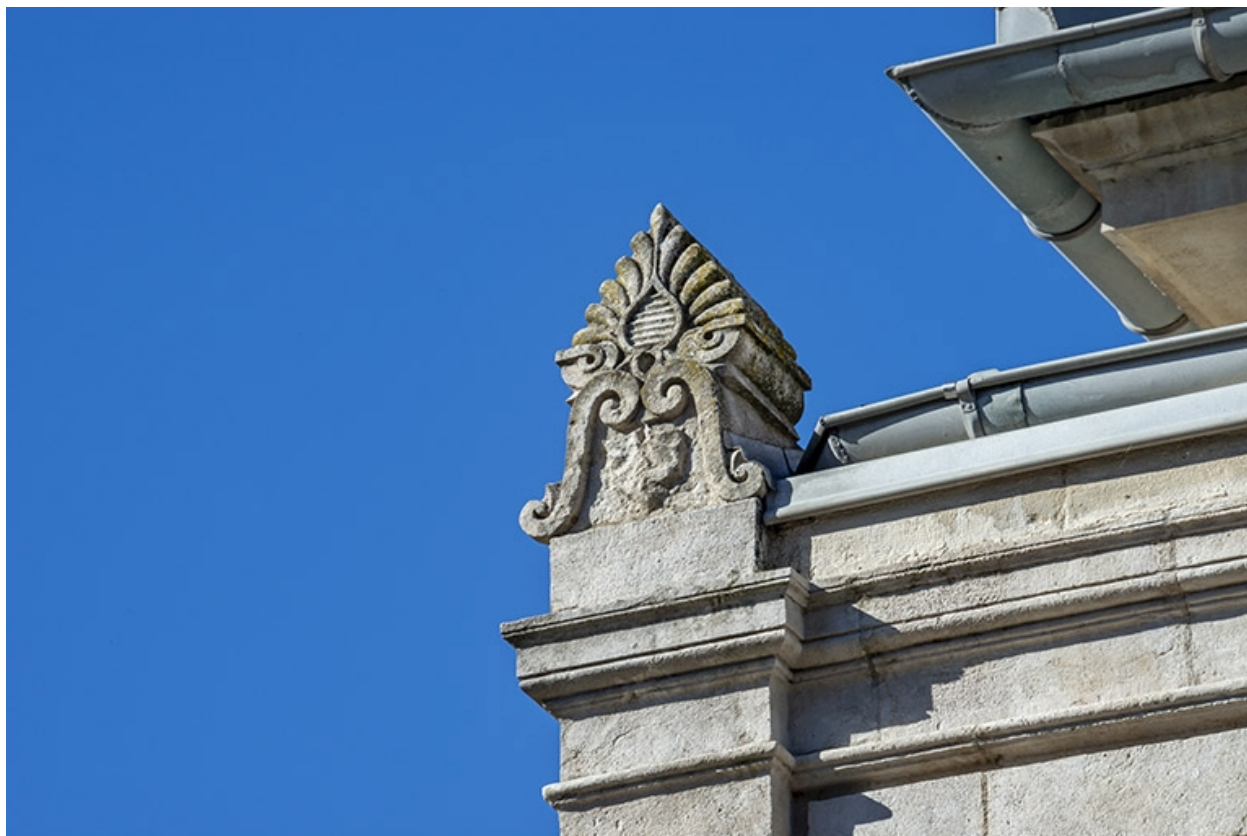
Façade antérieure : motif d'amortissement.
