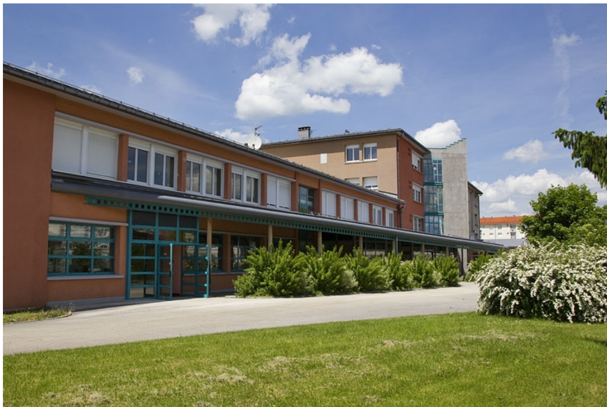
Bâtiment de la restauration.
