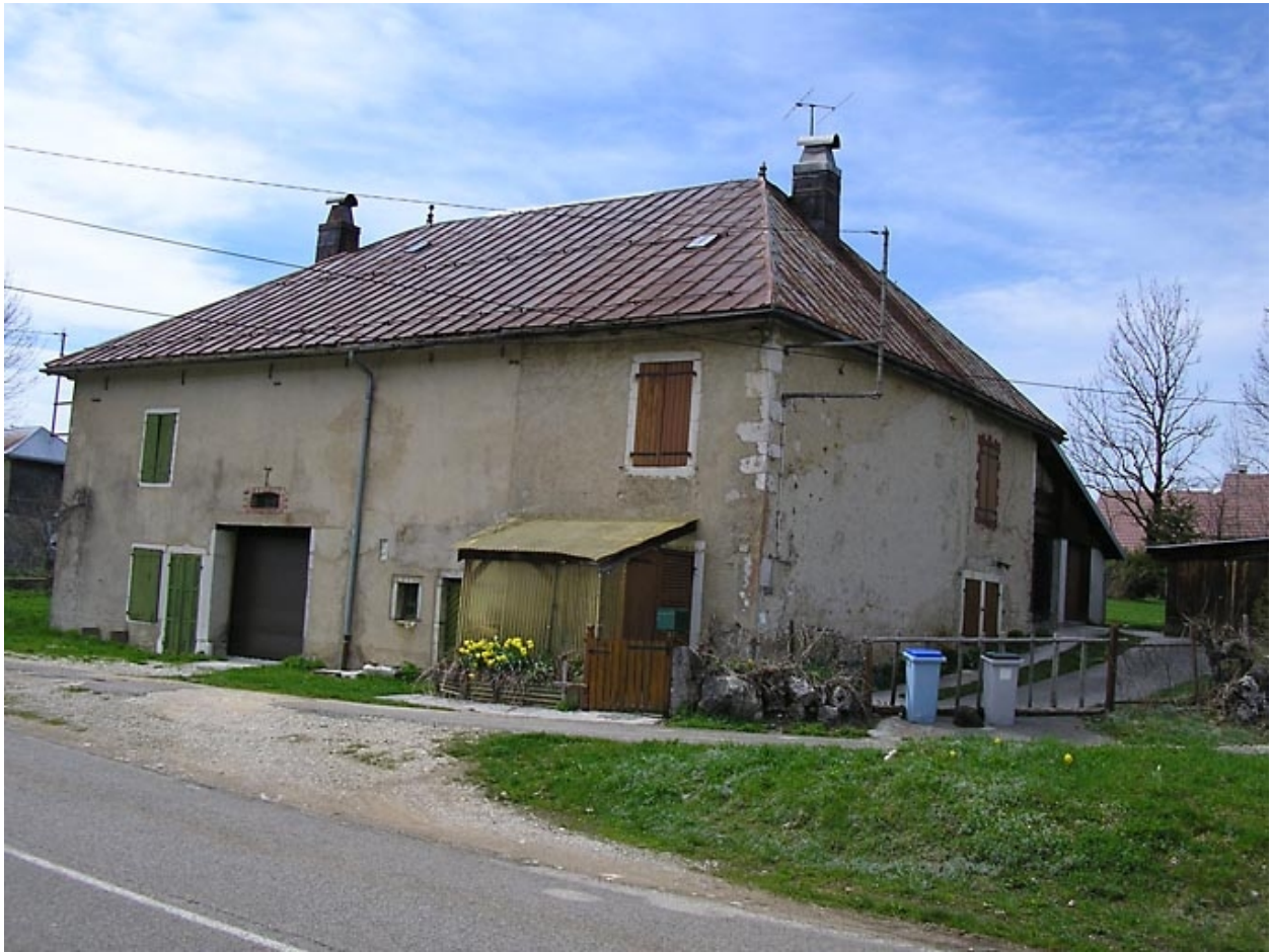
Ferme située au lieu-dit Le Maréchet.
