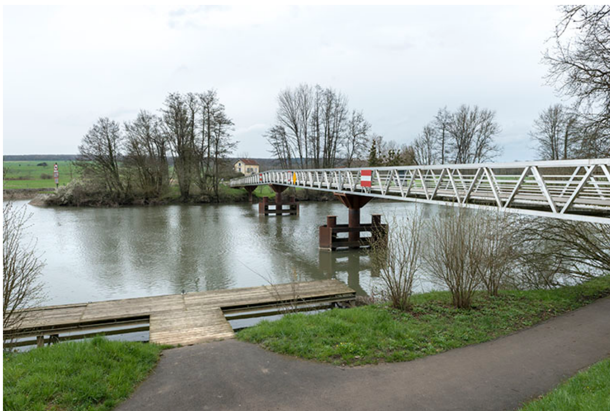
Passerelle enjambant la Saône.
