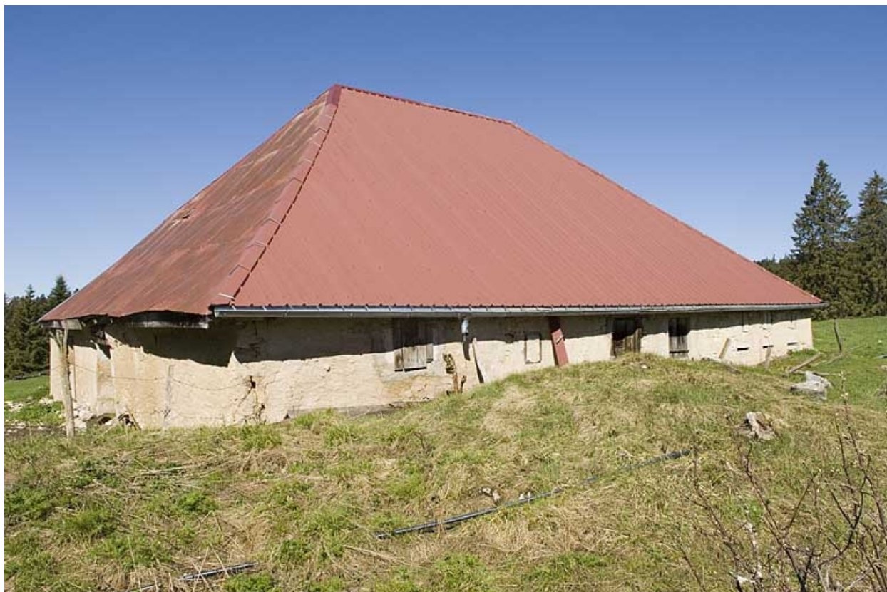
Façade postérieure et citerne.
