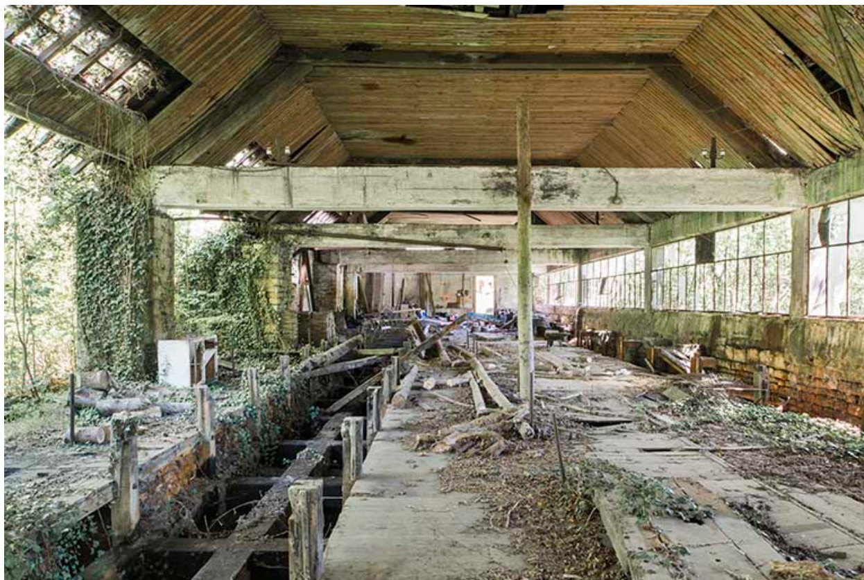
Atelier de tréfilerie. Vue intérieure depuis l'ouest.
