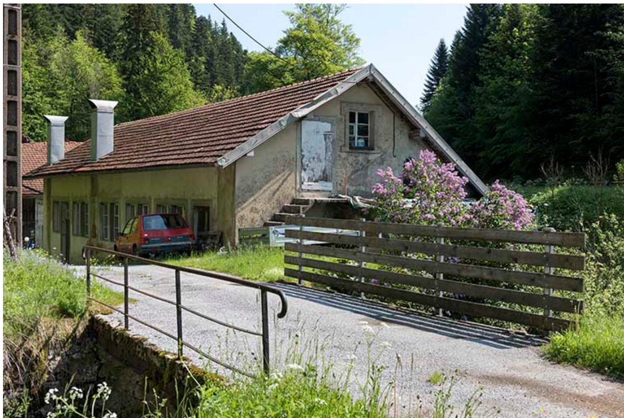
Usine : façades antérieure et latérale droite.
