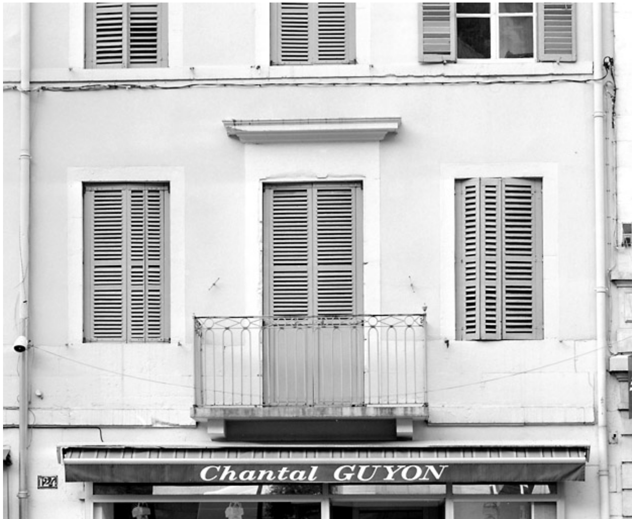
Premier étage du n° 124.
