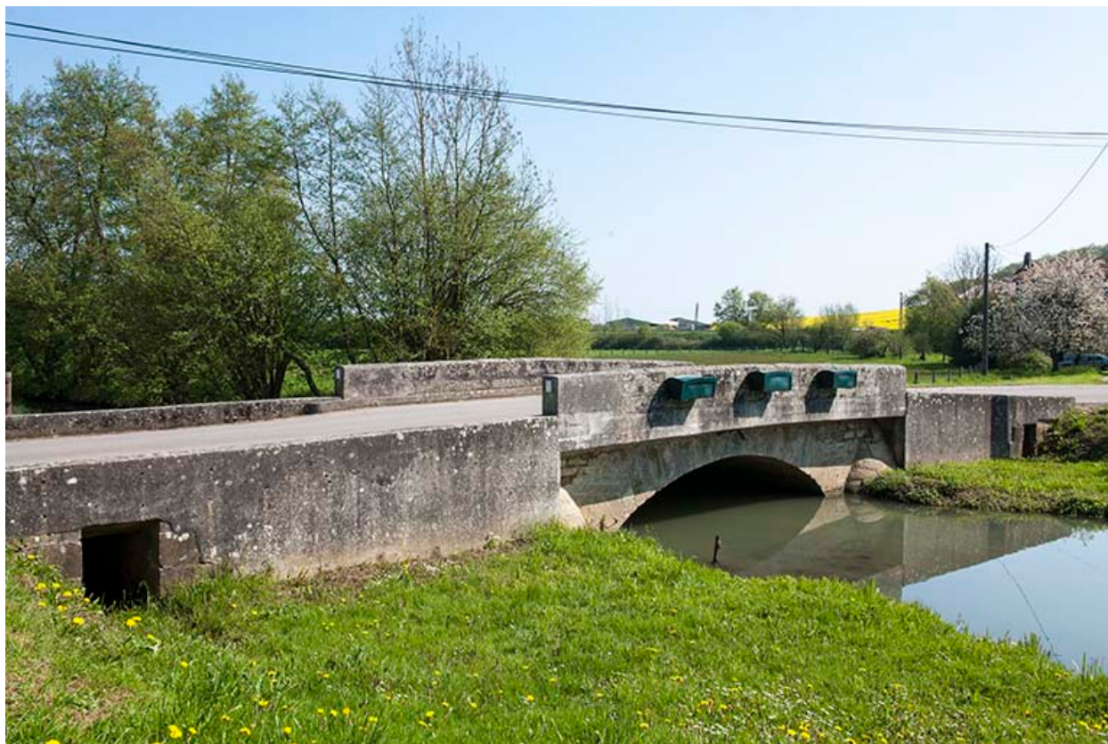
Le pont permettant de franchir le ruisseau.
