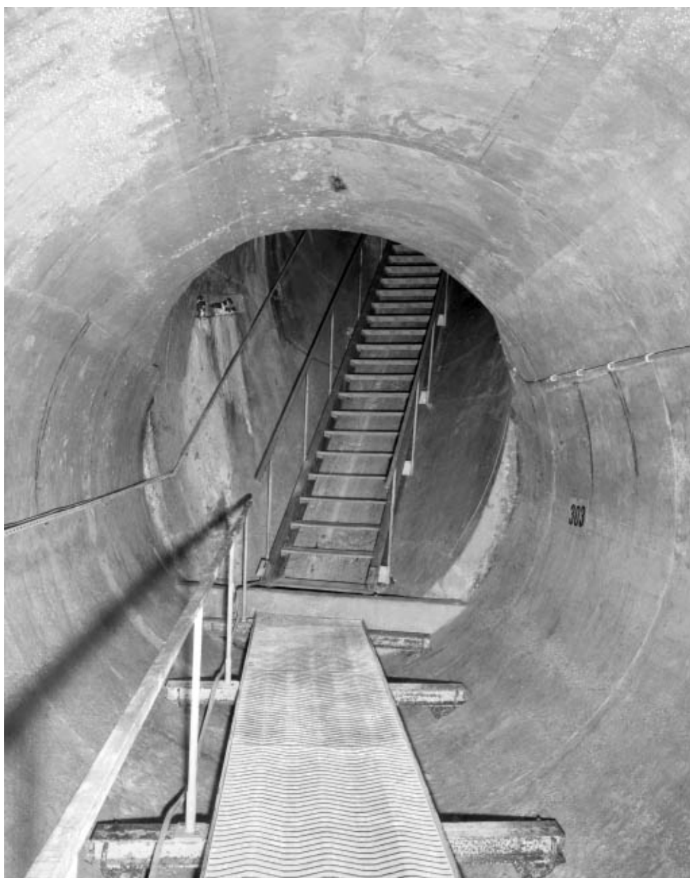
Extrémité inférieure de la "galerie de pied".
