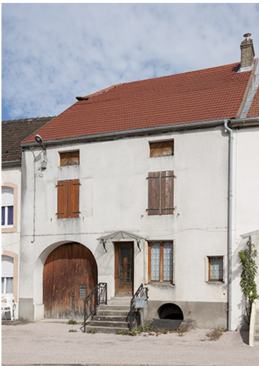
Ferme, 3 rue Arago : ferme à deux travées.
