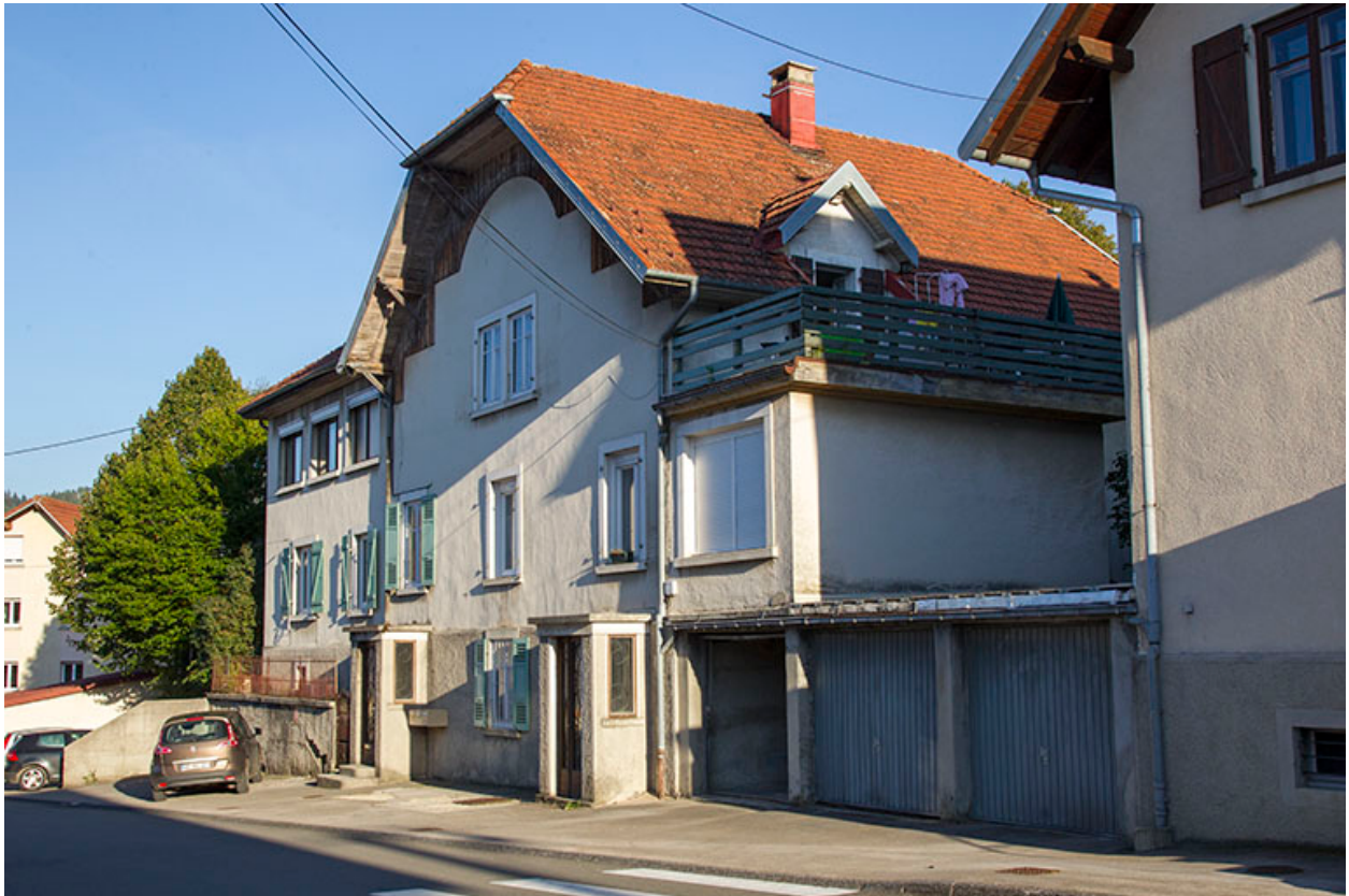
Maison : façade antérieure, vue en enfilade.
