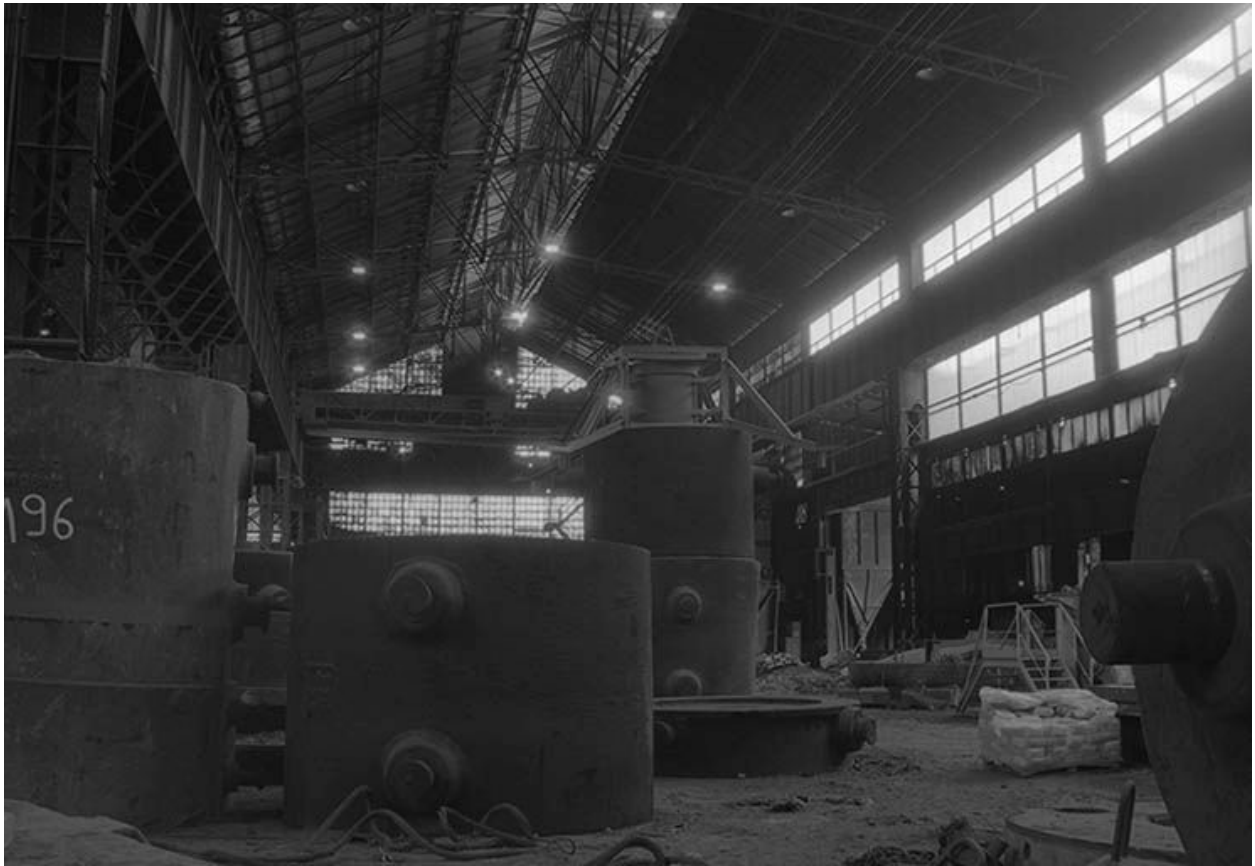
Extrémité nord de la halle des fours.
