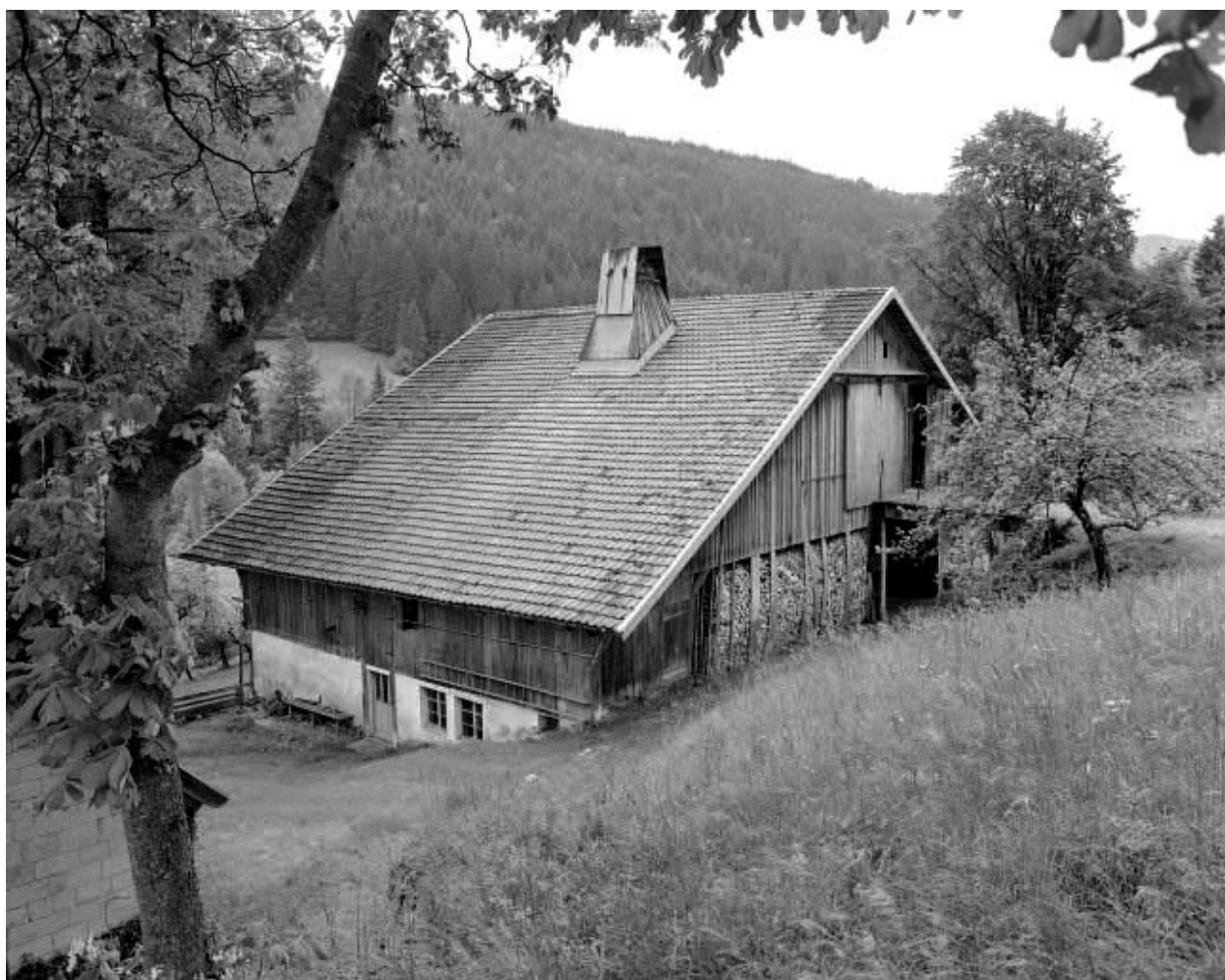
Extérieur : façades postérieure et latérale droite.
