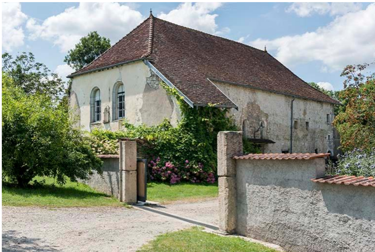
Vue de la chapelle, côté cour
