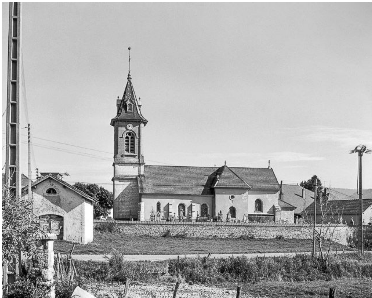
Façade latérale droite.
