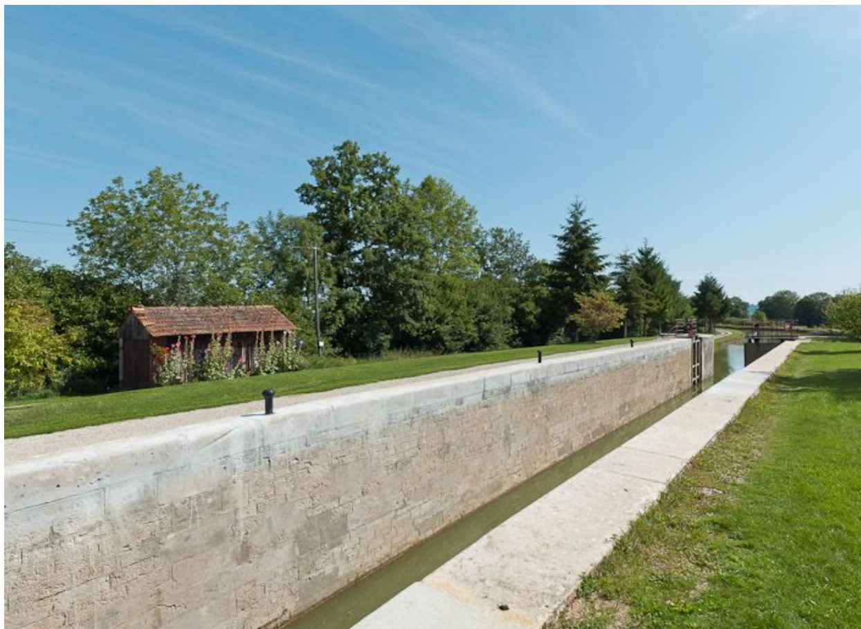
Vue du sas d'écluse.
