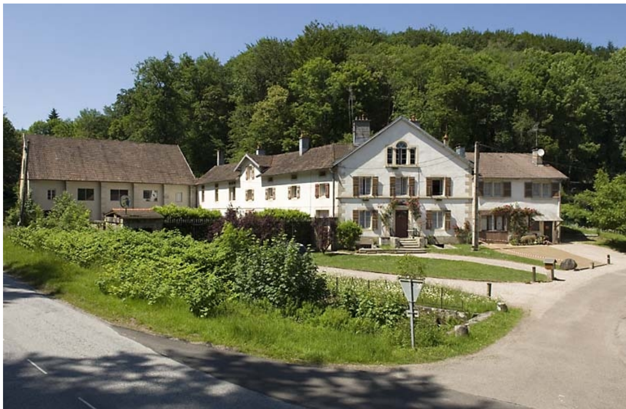
Ecole et logement (commune du Clerjus, 88).
