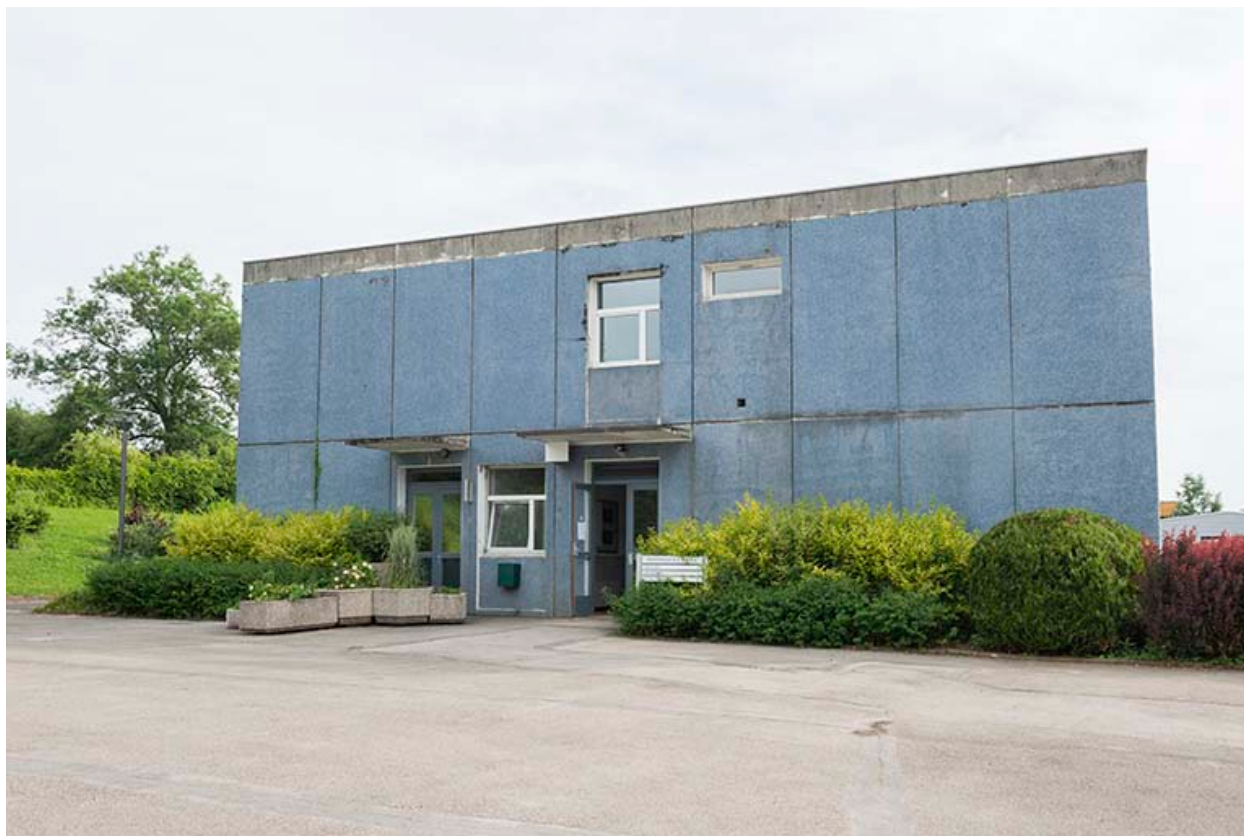
Détail du pignon sud-ouest de l'externat.
