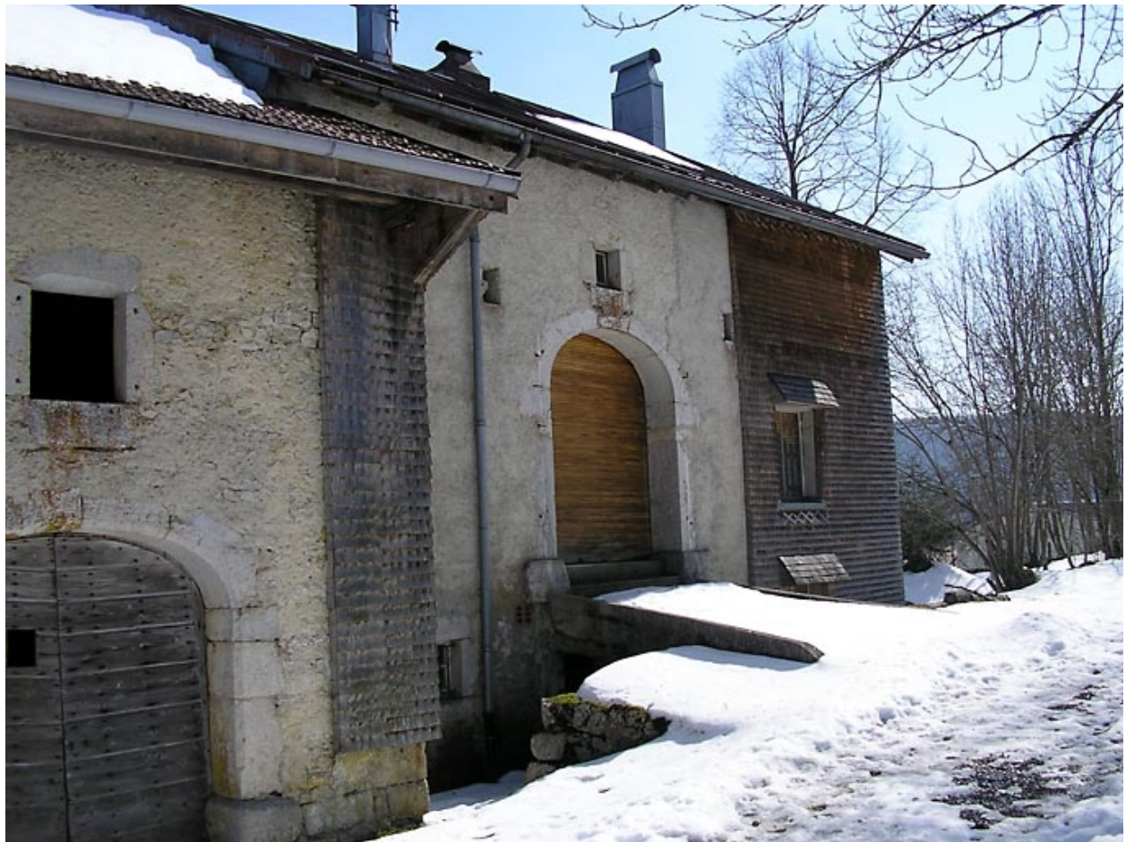
Ferme située au lieu-dit Les Jeannez.
