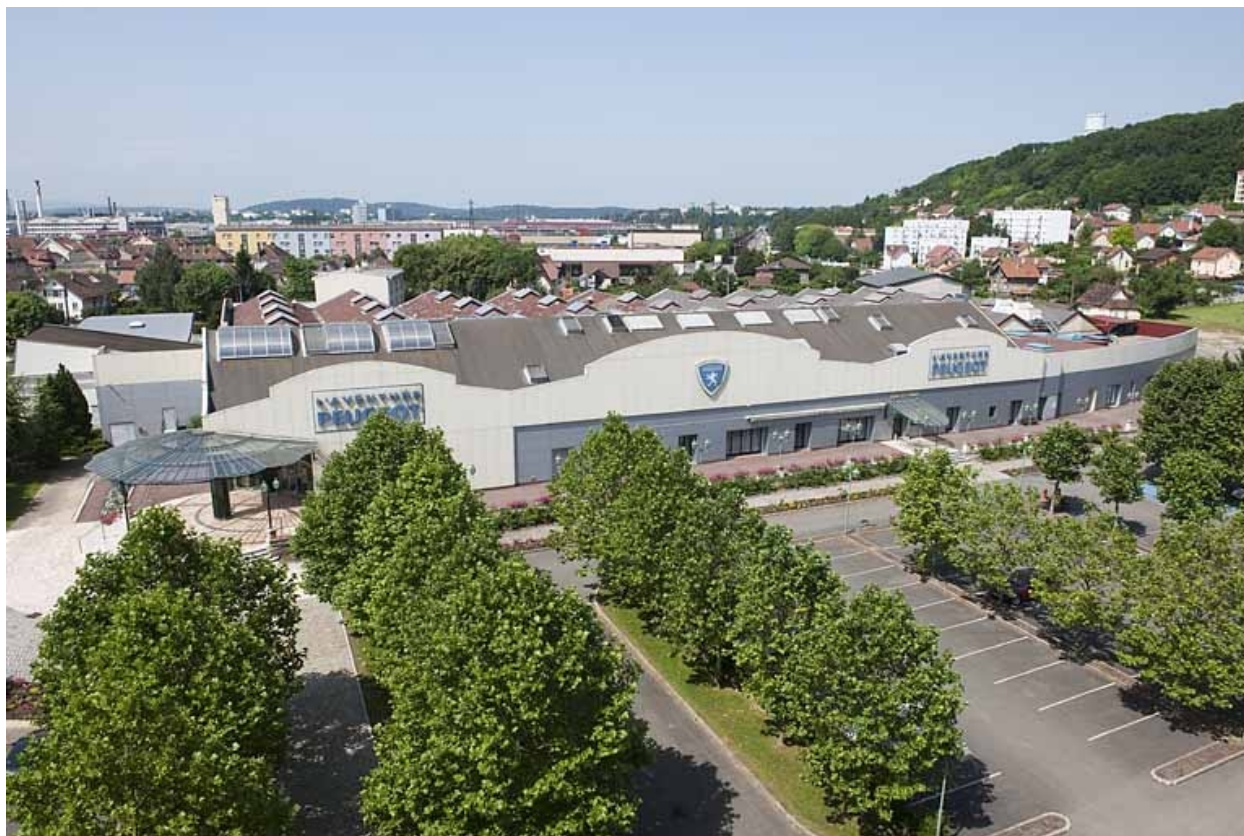
Vue plongeante sur le bâtiment du musée.
