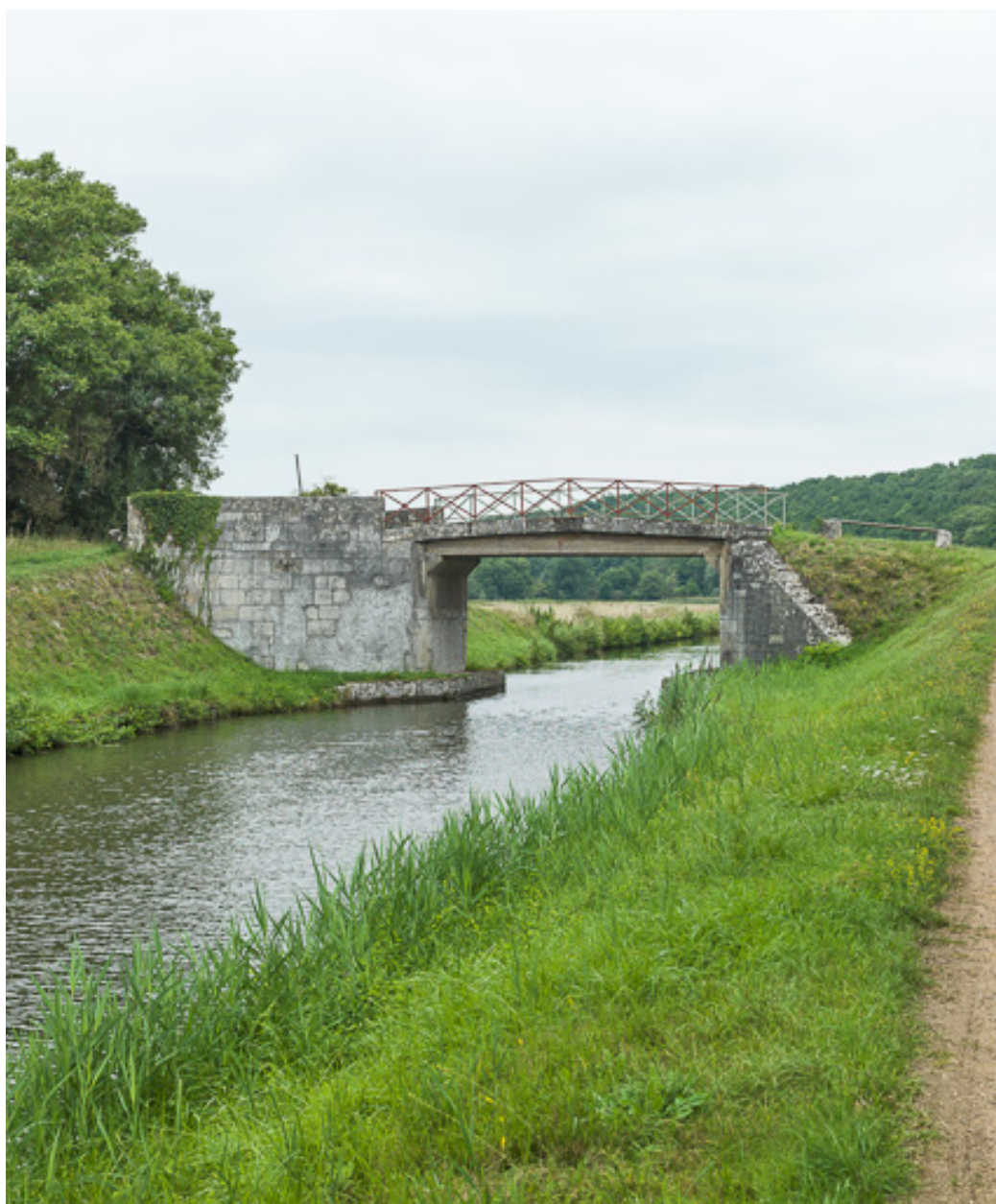
Vue du pont.
