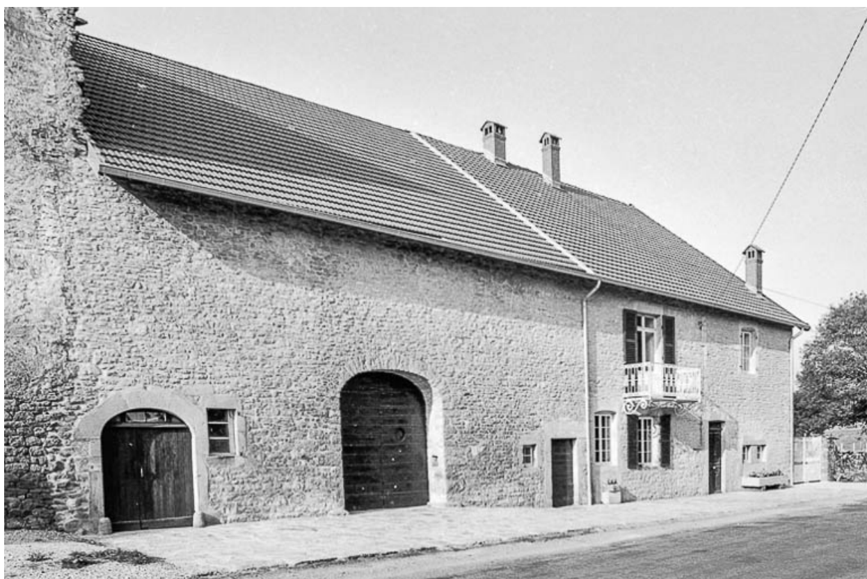
Ferme cadastrée A3 218 : façade antérieure.
