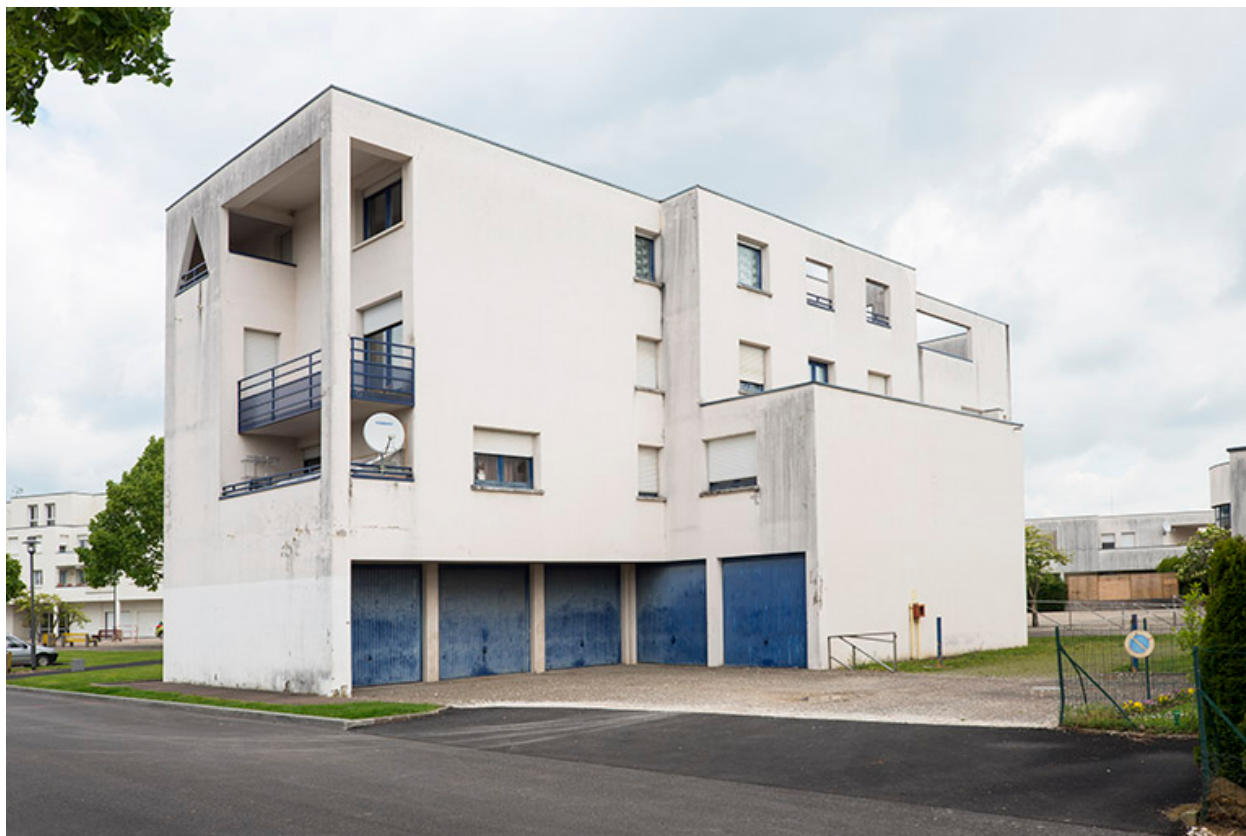
Angle sud-ouest des logements ouest.
