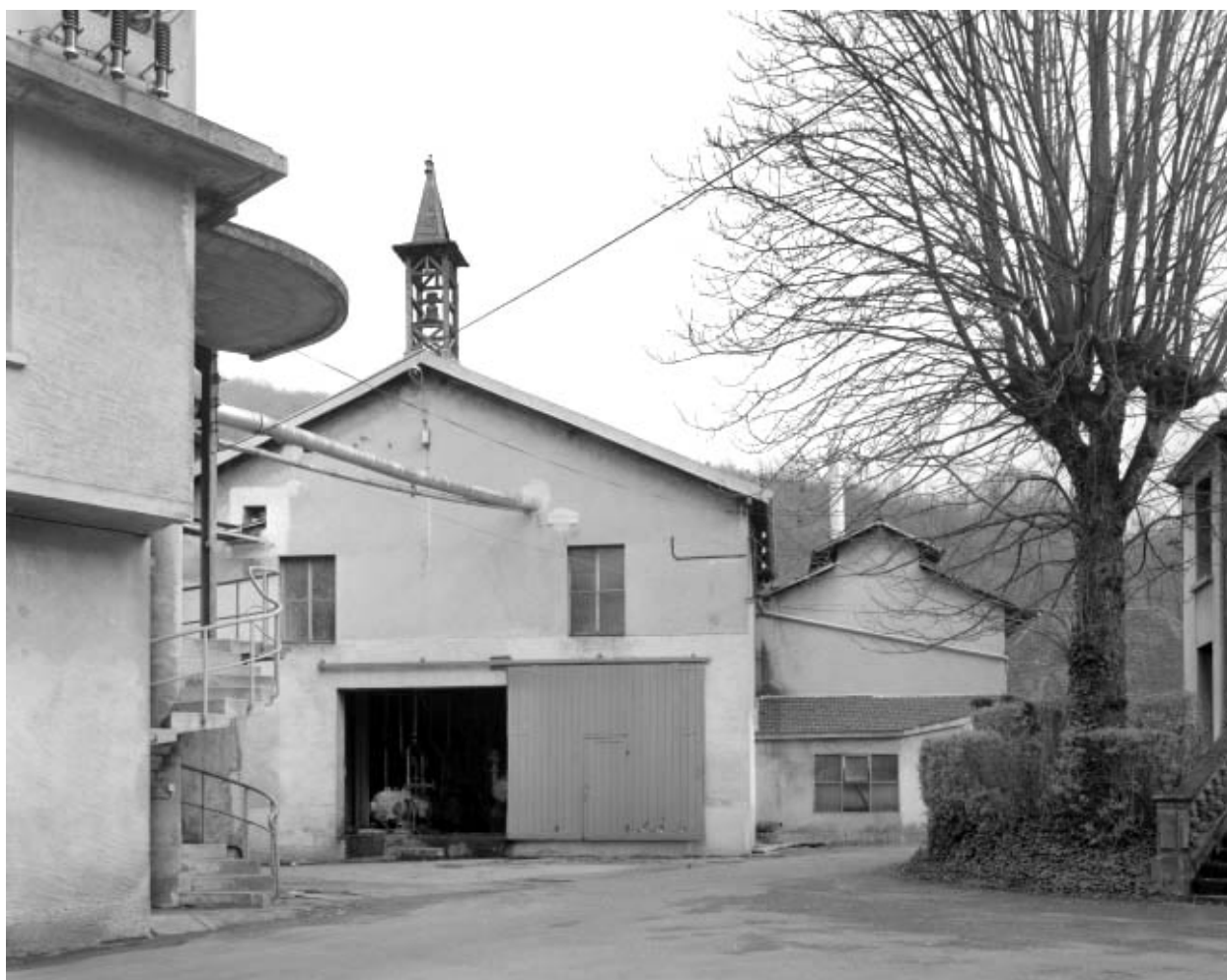
Atelier de fabrication et chaufferie.
