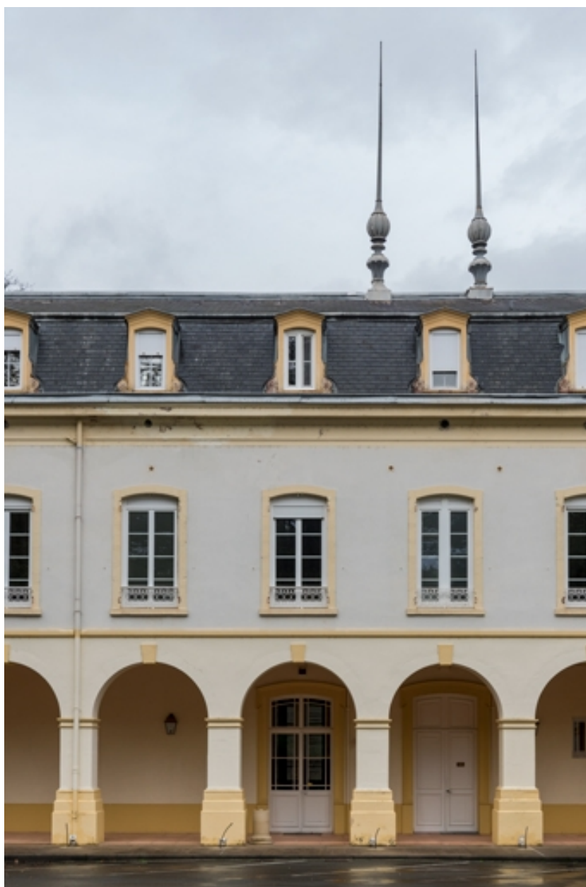
Cour, détail de l'aile nord.
