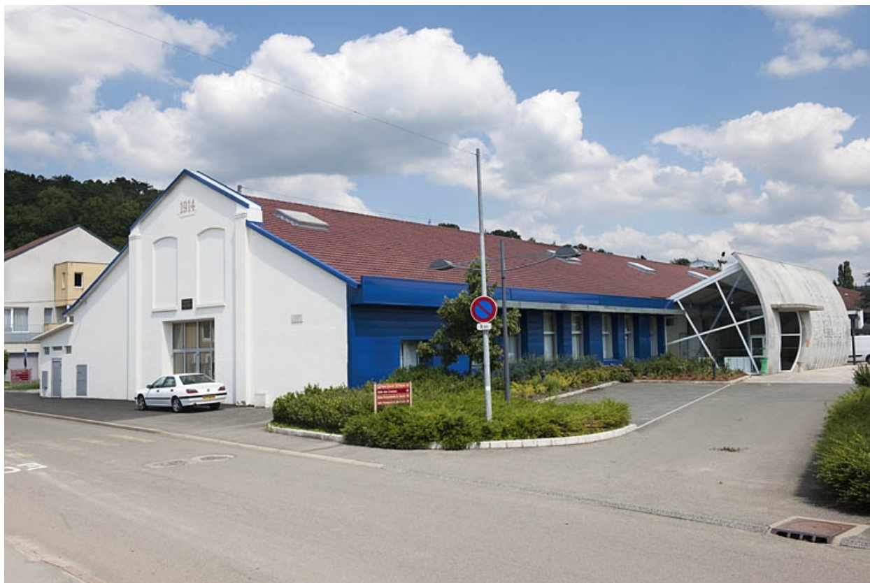
Fonderie et usine de construction mécanique des Ets Cuvier Fils puis Wyss et Cie, Seloncourt (rue de la Fonderie).
