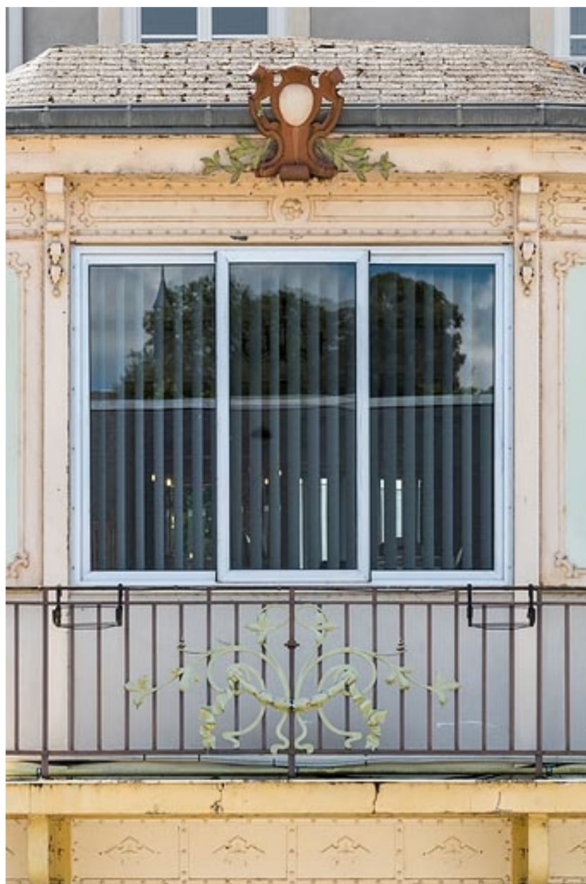
Aile ouest, salle à manger, détail.
