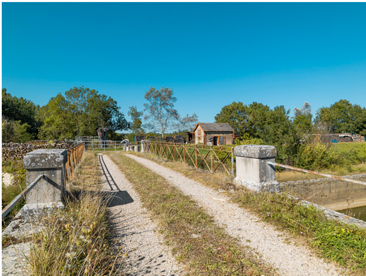
Vue d'ensemble du pont sur l'écluse.
