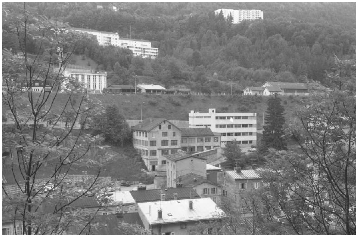
Vue d'ensemble depuis l'ouest.
