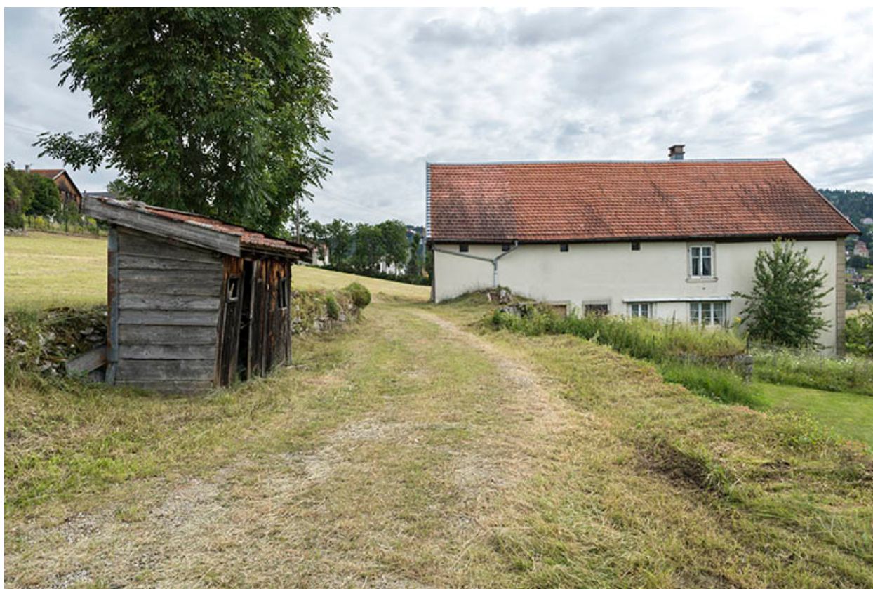
Vue d'ensemble, depuis l'ouest.
