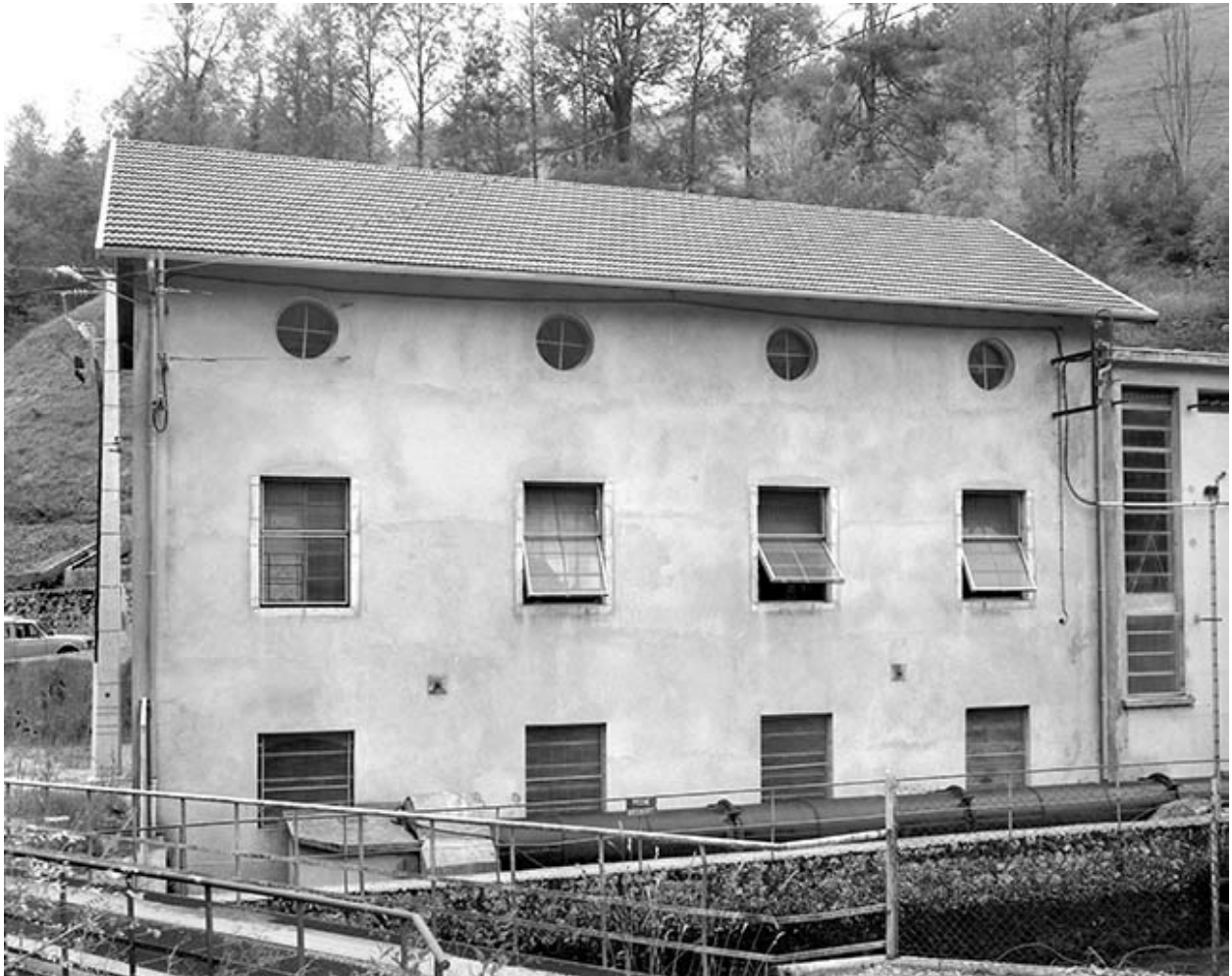
Façade postérieure du bâtiment d'eau.
