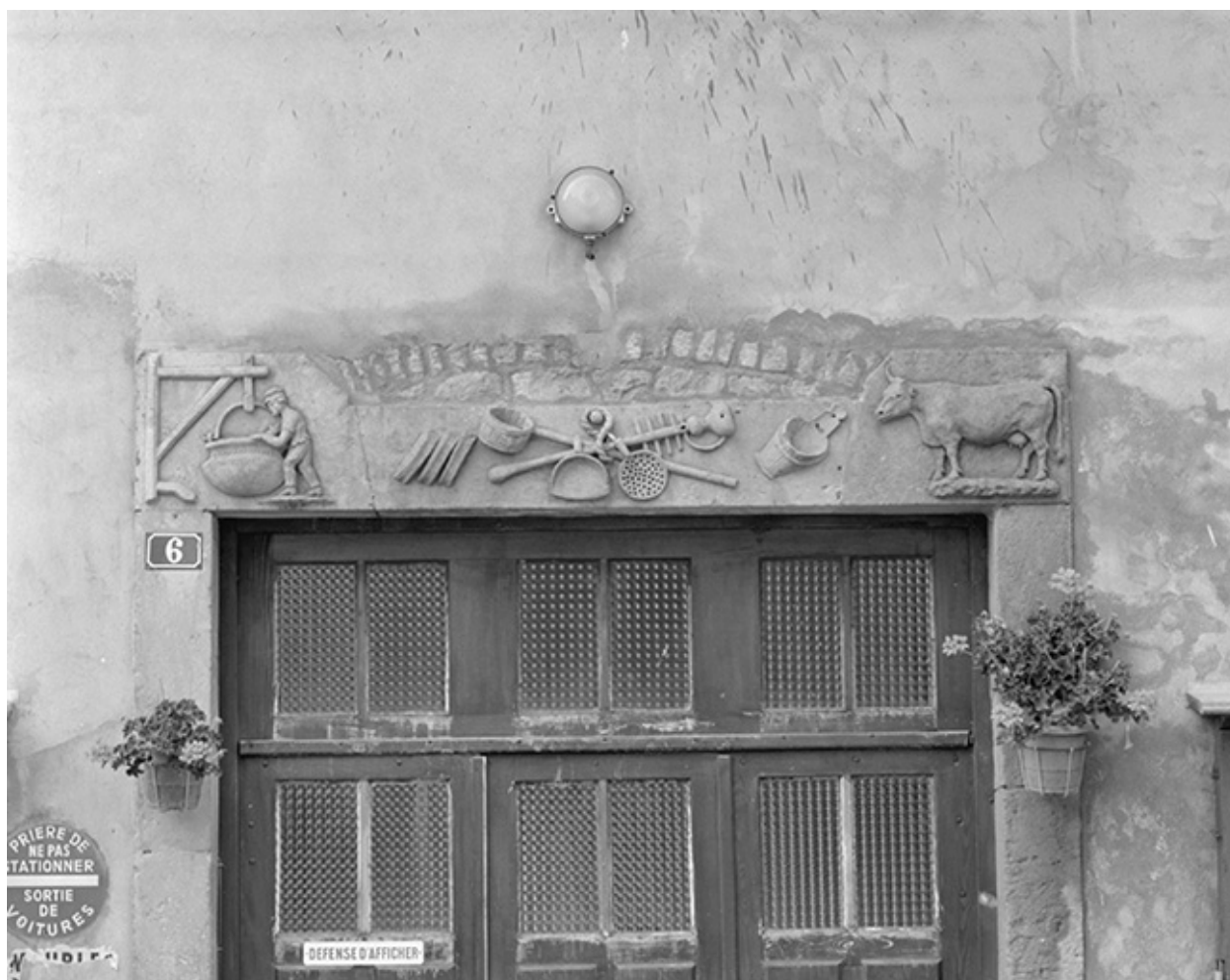
Linteau de la porte d'entrée en 1979.
