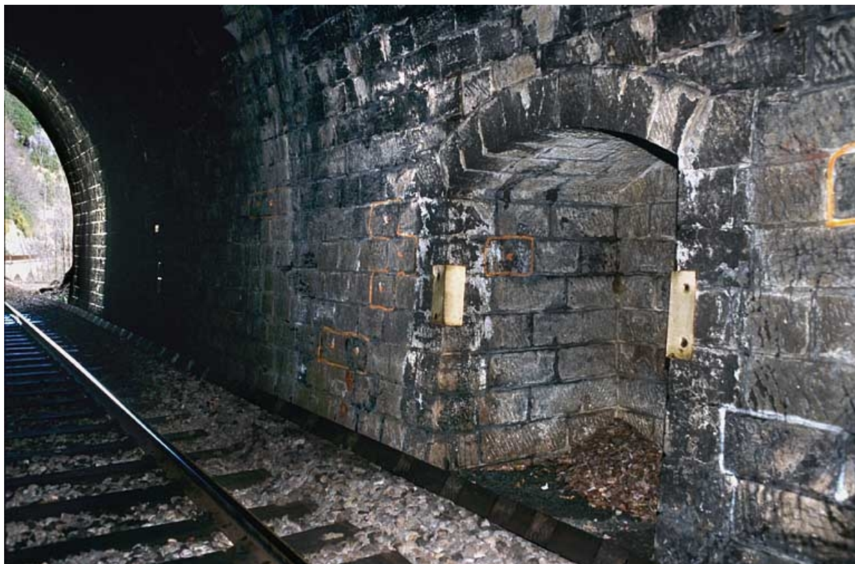
Tunnel du Champ de Bienne : refuge.
