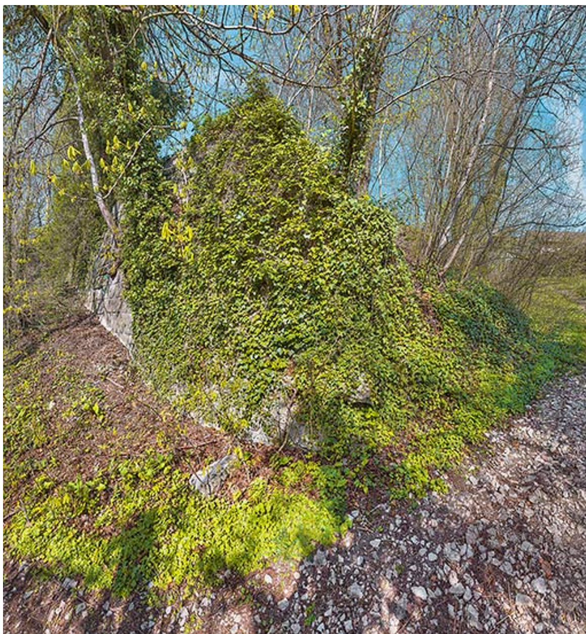
Tronçon de rempart ruiné.
