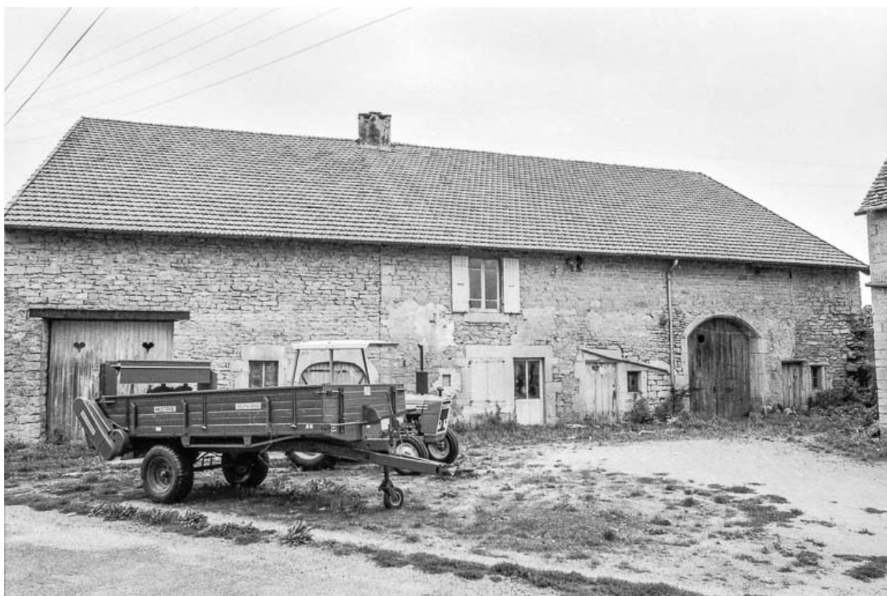
Ferme cadastrée 1951 E1 268 : façade antérieure.
