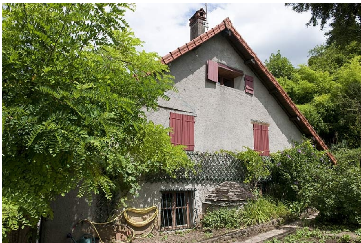
Façade latérale droite.
