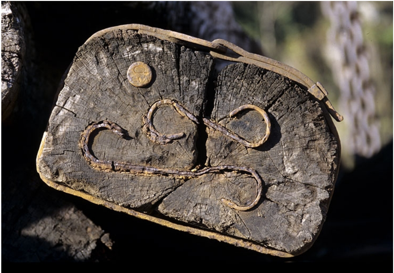
Extrémité d'une traverse avec frettage Delor, esses et clou.
