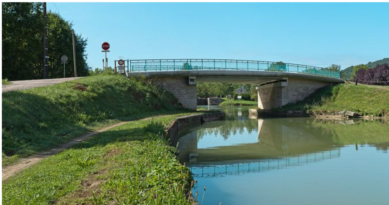
Vue du pont.
