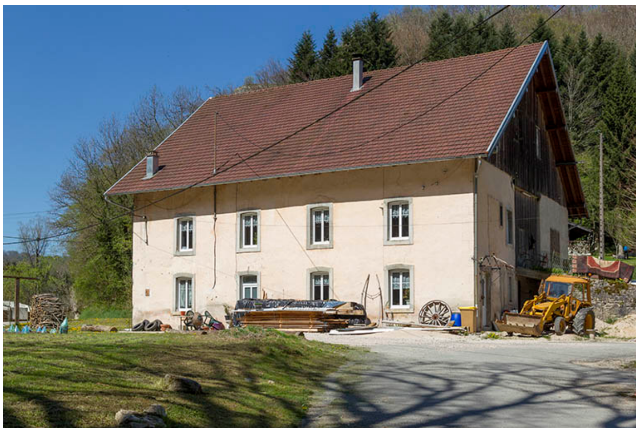
Site du moulin : logement d'ouvriers, depuis l'ouest.
