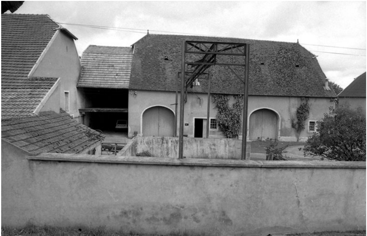
Vue du bâtiment agricole.
