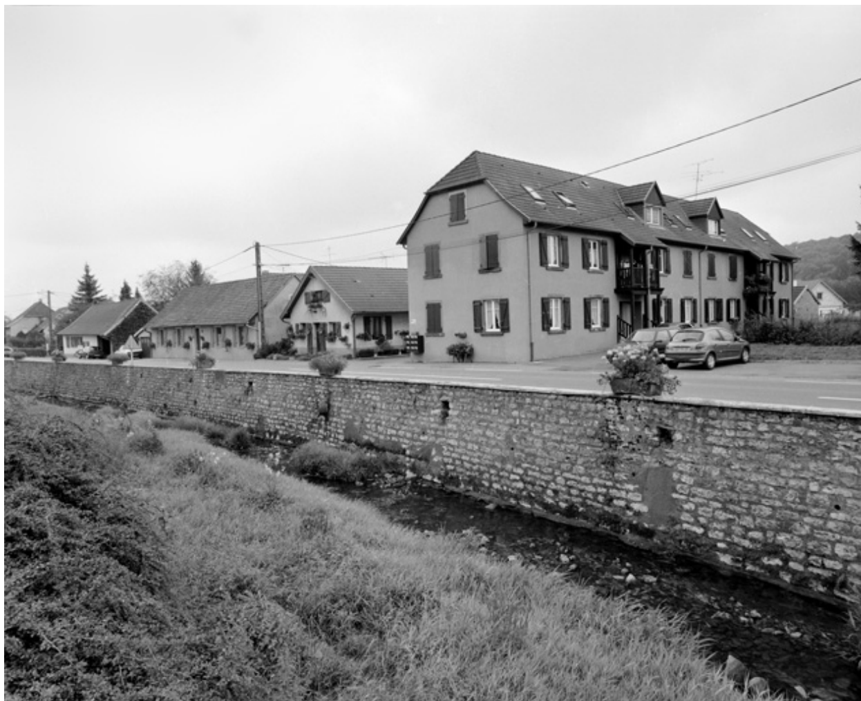
Vue d'ensemble des logements ouvriers.
