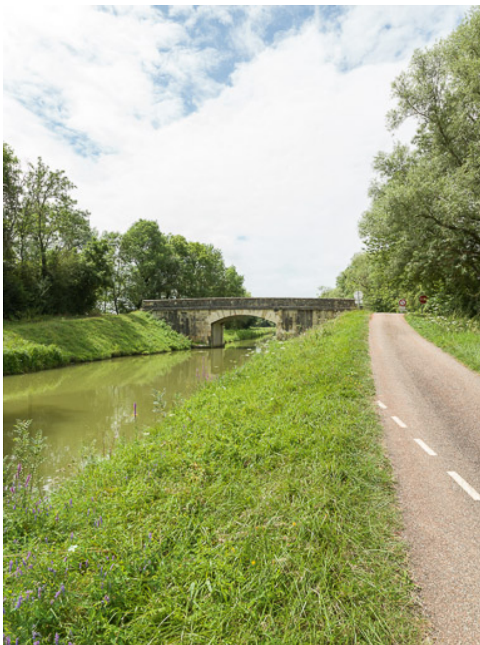
Vue d'ensemble du pont et du site.
